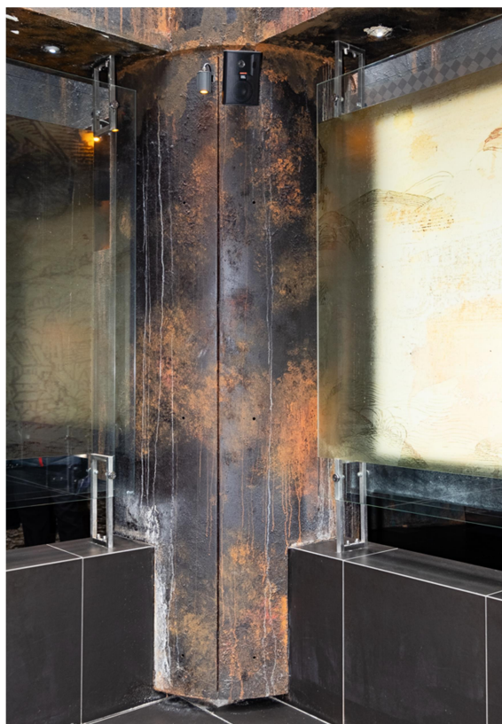
Ryc. 18. Zacieki na obudowie słupów żelbetowych
