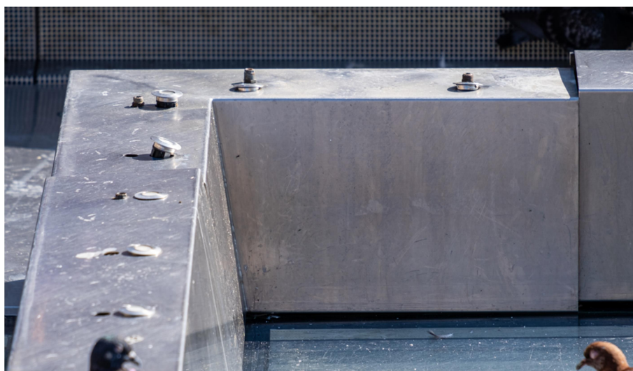
Ryc. 2. Obluzowanie blach maskujących i elementów systemu dysz i oświetlenia
