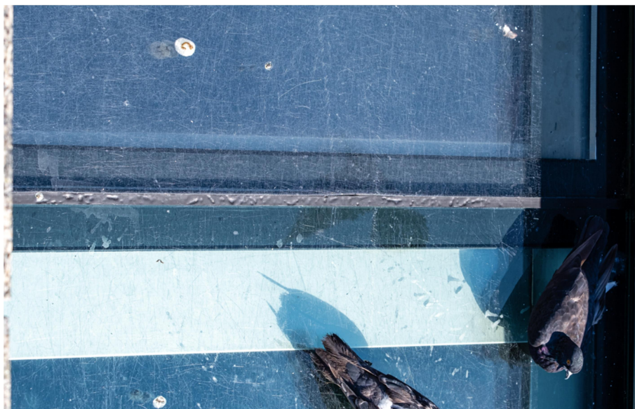
Ryc. 17. Degradacja uszczelnienia między płytami niecki
