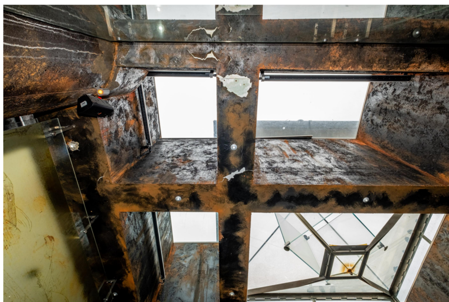
Ryc. 20. Odspojenie warstw wykończeniowych żelbetowego rusztu od strony muzeum
