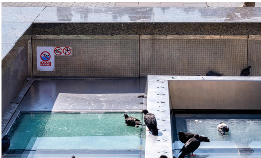
Ryc. 2. Blacha perforowana maskująca przestrzeń wnętrza w ścianie obwodowej pod płytami kamiennymi
