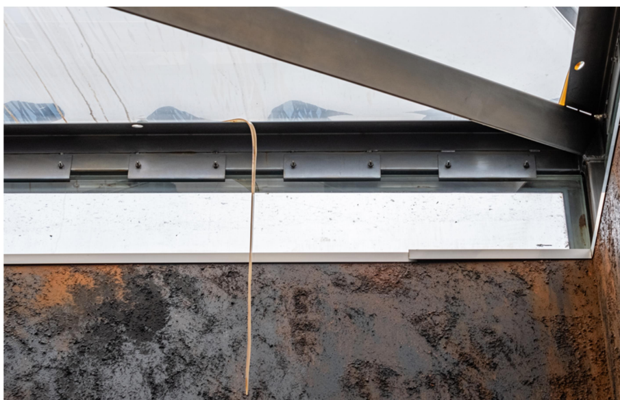
Ryc. 18. Przemieszczenie podkładki uszczelniającej spod elementów fontanny
