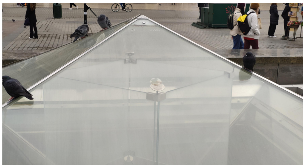
Ryc. 5. Przemieszczenie elementów dystansowych pod taflą górnego ostrosłupa
