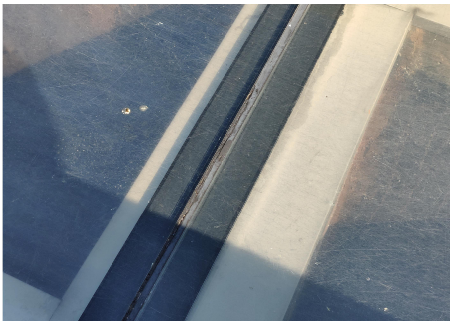
Ryc. 16. Degradacja uszczelnienia między płytami niecki
