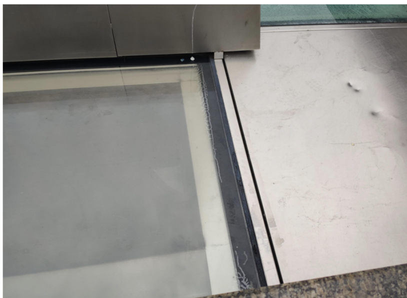
Ryc. 7. Szklana płyta niecki z widoczną siatką pęcherzyków powietrza - objaw delaminacji
