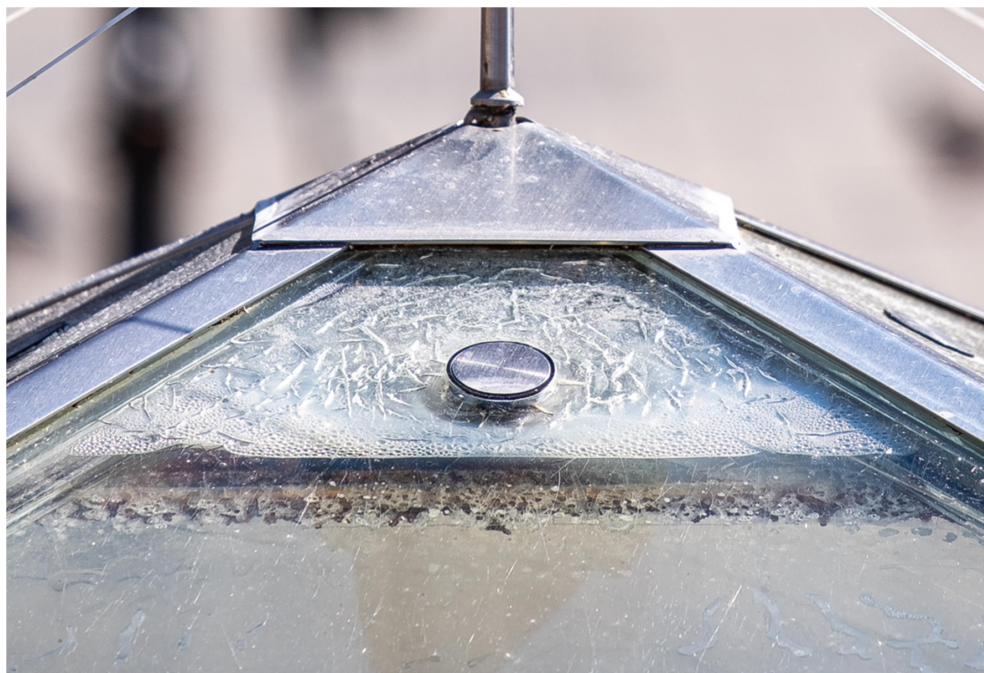
Ryc. 4. Spękanie fragmentu tafli kopuły górnej przy wierzchołku
