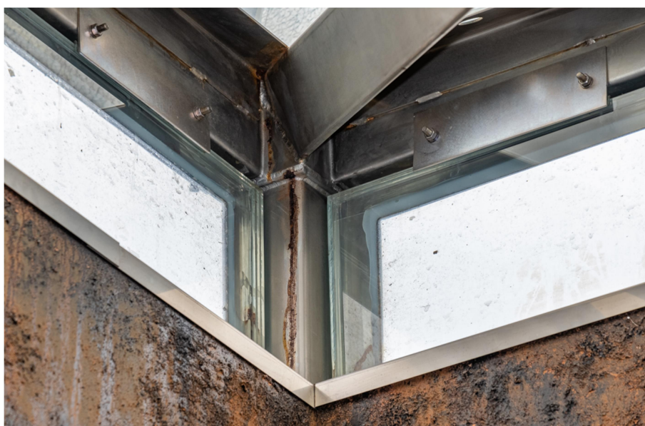
Ryc. 12. Zacieki po wewnętrznej stronie przegród pionowych fontanny
