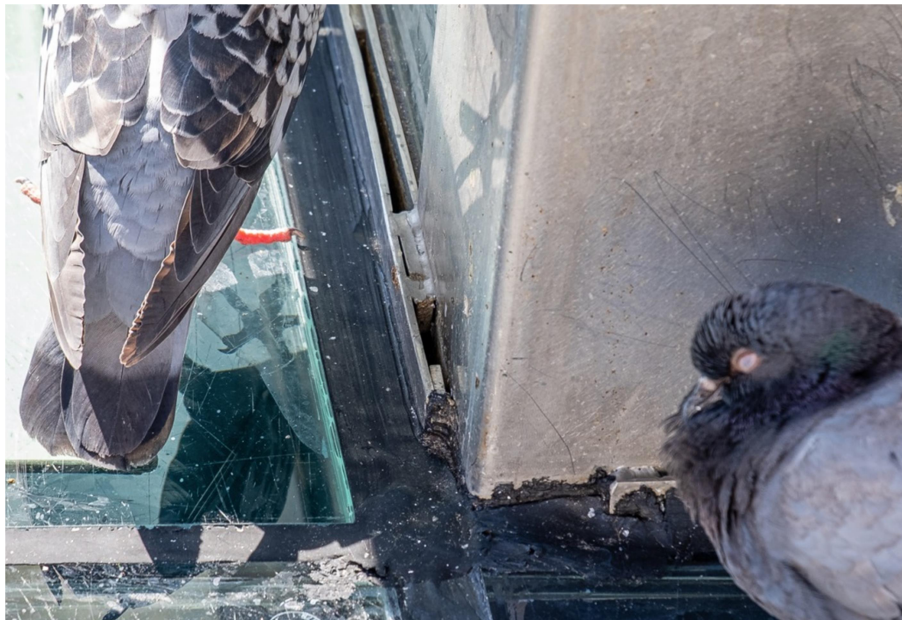
Ryc. 13. Szczeliny na poziomie niecki u podstawy przegrody pionowej fontanny
