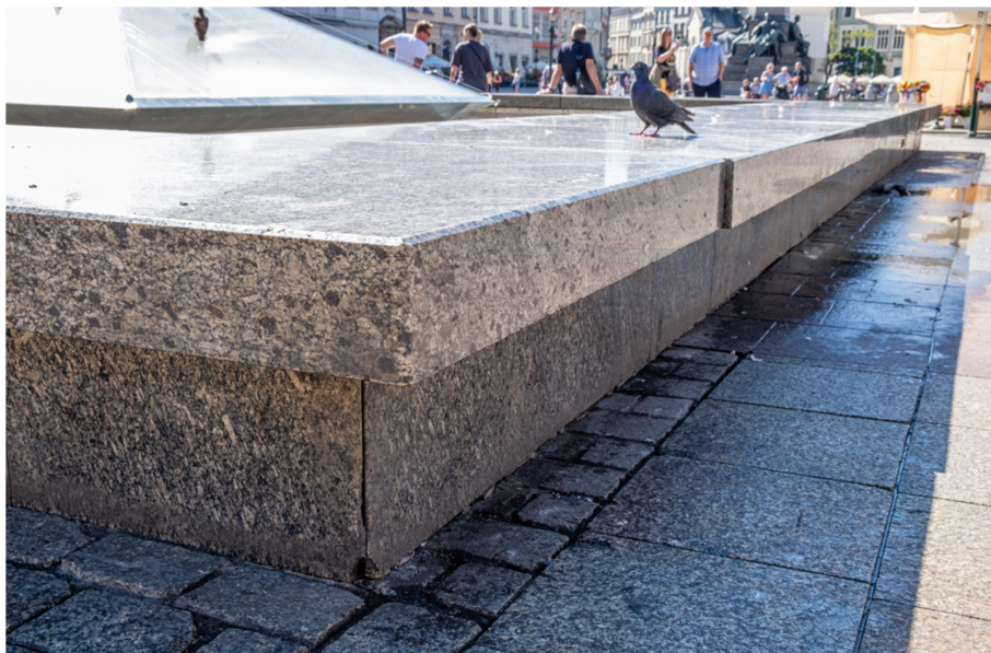
Ryc. 9. Przemieszczenia i uszkodzenia płyt kamiennych formujących cokół i siedzisko fontanny
