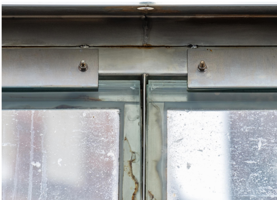
Ryc. 14. Zanieczyszczenia między szkleniem a izolacją
