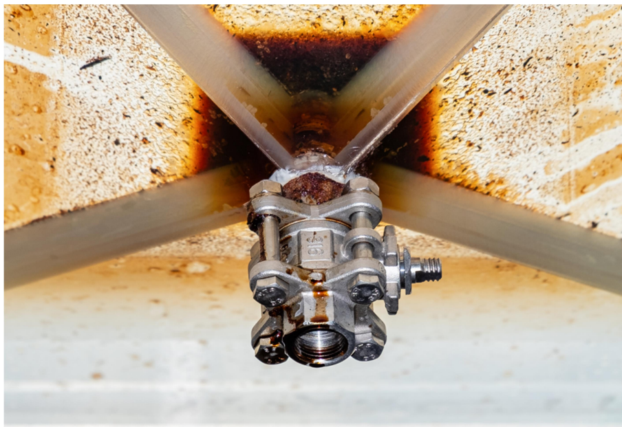
Ryc. 15. Zawór układu napełniania gazem w dolnym ostrosłupie fontanny
