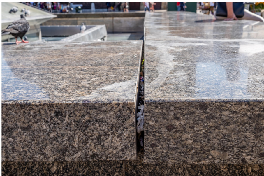
Ryc. 10. Gromadzenie się zanieczyszczeń w powstałych przestrzeniach między płytami
